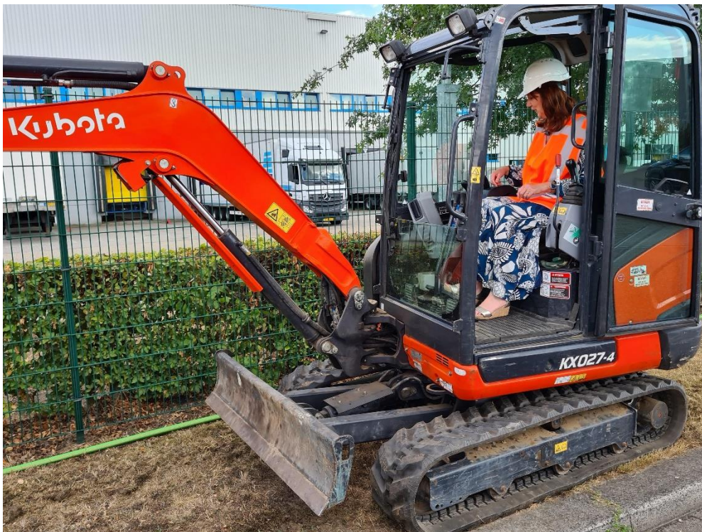
Wethouder Angely Waajen van Roermond start de graafwerkzaamheden op Roerstreek (21-8)
